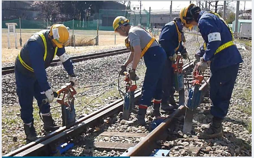
図2 HTTを用いたつき固め作業
