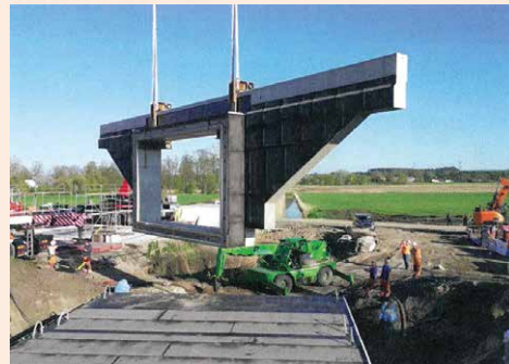
Graben 高架橋プロジェクトにおけるプレキャスト部材のつり上げ作業 (出典 : Konigbau 社) 《出典 Der Eisenbahningenieur》
