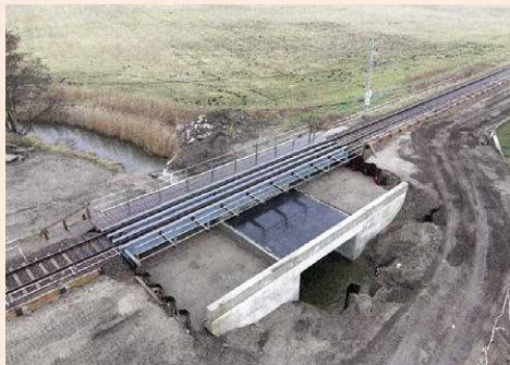
仮設桁下部における Welse 高架橋の建設工事 (出典 : Konigbau 社) 《出典 Der Eisenbahningenieur》
