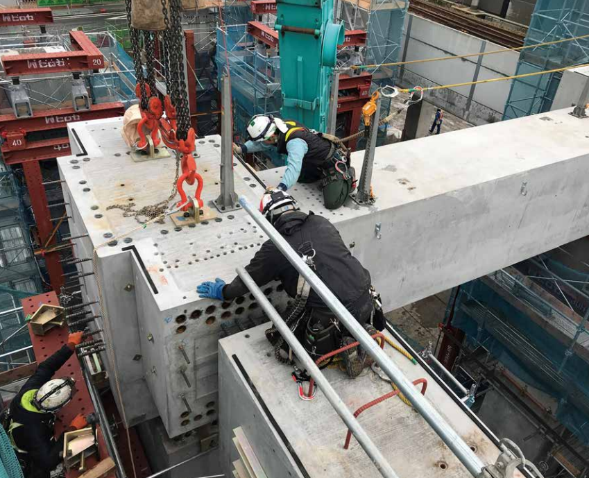
図2 新幹線高架橋での施工
