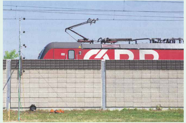
高所の騒音源を直接見通しが可能な高さ 2m の防音壁の例 《出典 Eisenbahntechnische Rundschau》
