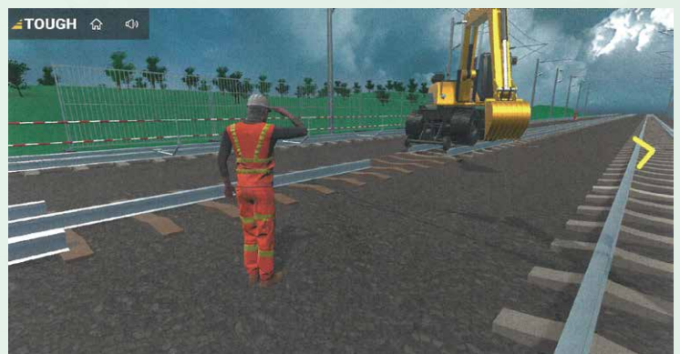
双方向掘削機に注意すること：シャベルに近づきすぎたり機械の後ろに立ったりすると受傷の危険性がある。 《出典 Eisenbahntechnische Rundschau》
