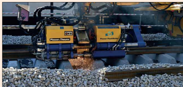
多くの試験現場で稼働中の Plasser FlashWelder
