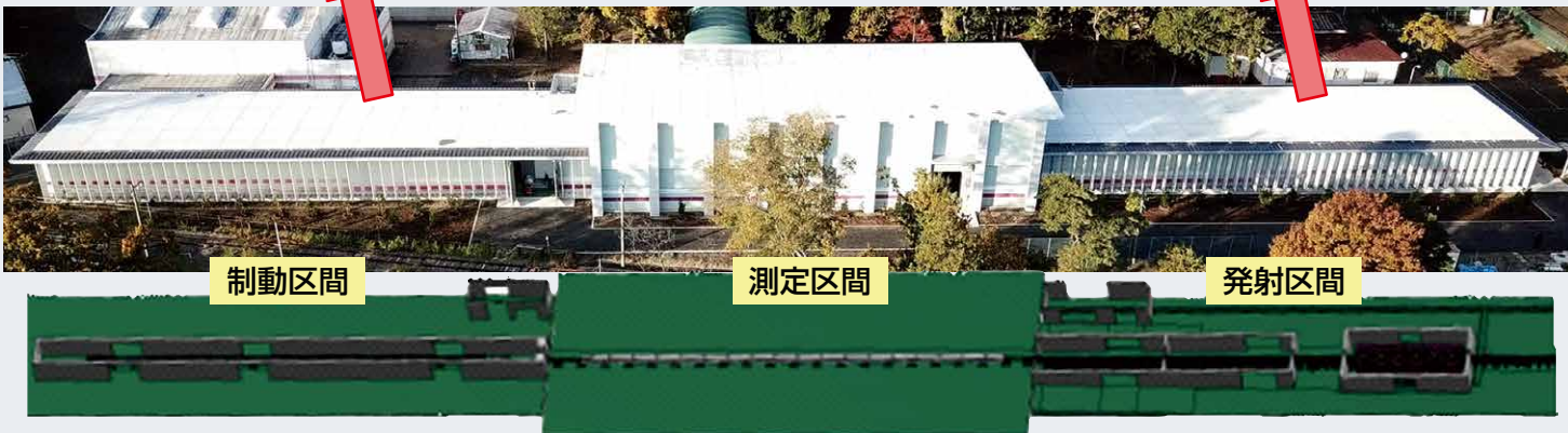
図5 低騒音列車模型走行試験装置（低騒音走行装置）
