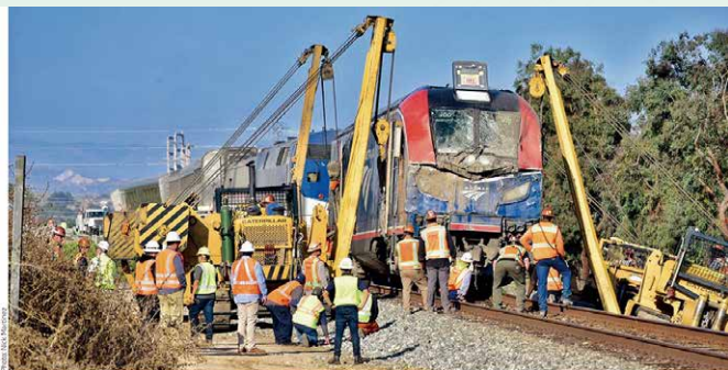
踏切は依然として米国の鉄道網における安全に関する事故の重大な原因箇所となっている。アムトラックの最初のALC-42電気式ディーゼル機関車は、最近ムアパークで起きたコーストスターライト列車のトラックとの衝突事故でその衝突安全性を実証した。
