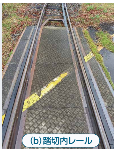
図7 手探傷で検査できないレール
