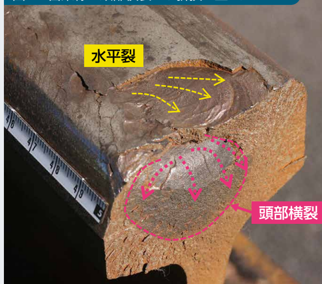
図2 営業線で頭部横裂から折損に至ったレール
