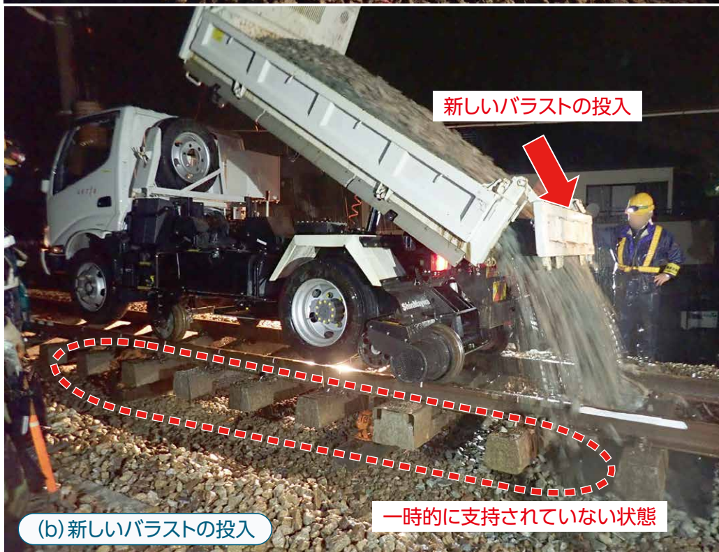
図1 バラスト交換作業の様子
