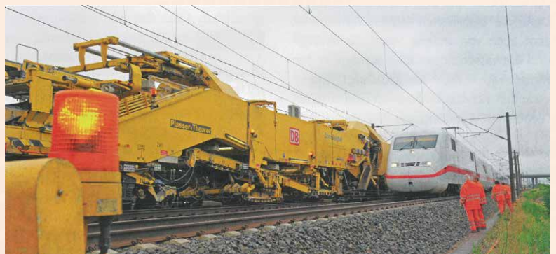
「列車運行」と「工事」は両立が可能 - ICE が通過する複線路線における大型機械の運用
