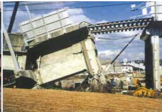
図3 兵庫県南部地震による鉄道の被害状況（文献2から引用）
