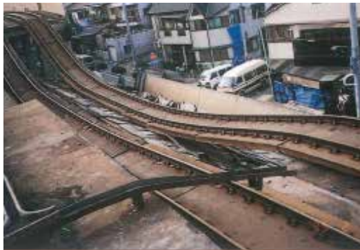
図3 兵庫県南部地震による鉄道の被害状況（文献2から引用）
