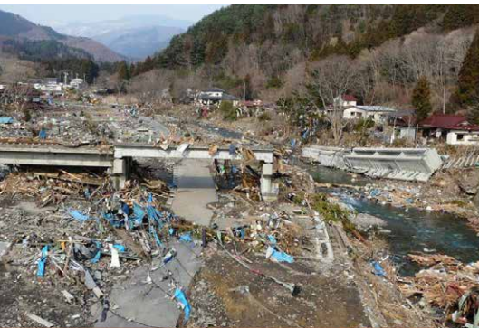
図2 三陸鉄道における被害状況
