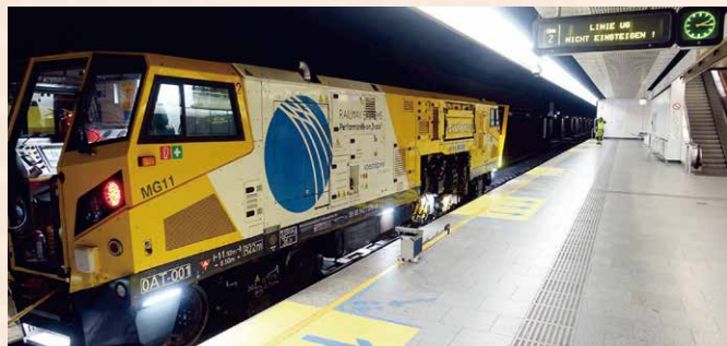
ウィーン地下鉄ネットワークに導入された Voestalpine Railway Systems の MG11 コンパクトミリング式レール削正車。
