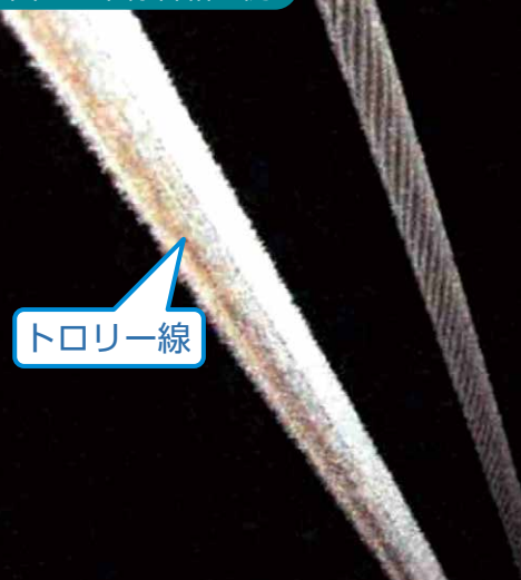
図2 架線着霜の例
