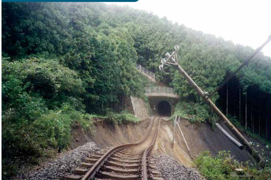
図1 降雨による斜面災害の例 1)
