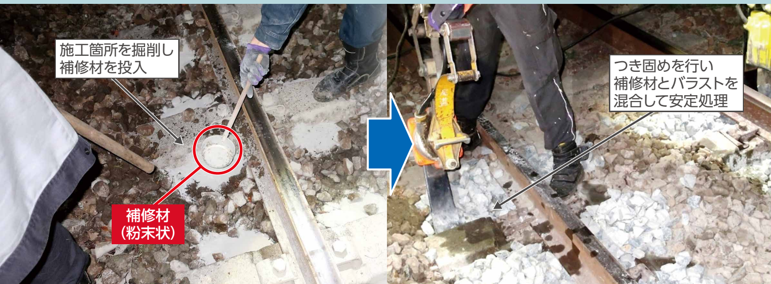
図2 低強度安定処理工法の施工（ハンドタイタンパーを用いた施工方法）
