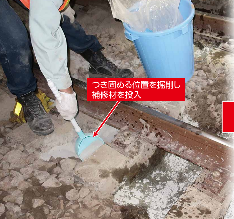
図4 低強度安定処理工法の施工方法（ハンドタイタンパー施工）
