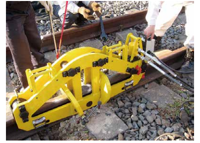
レール頭部きず補修 16)
