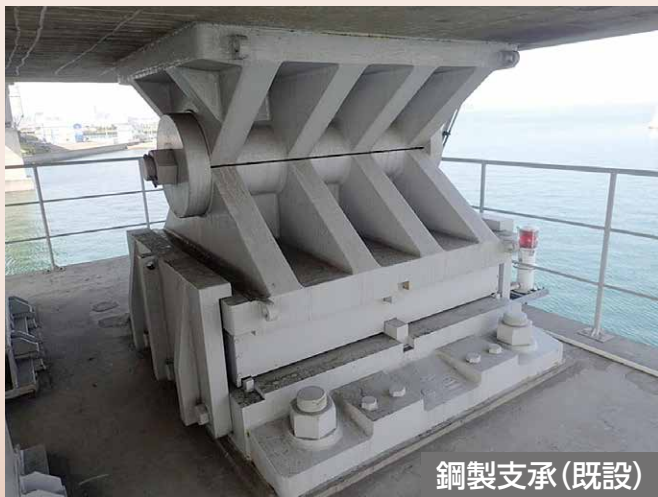
図7 免震・制震構造による補強の概要
