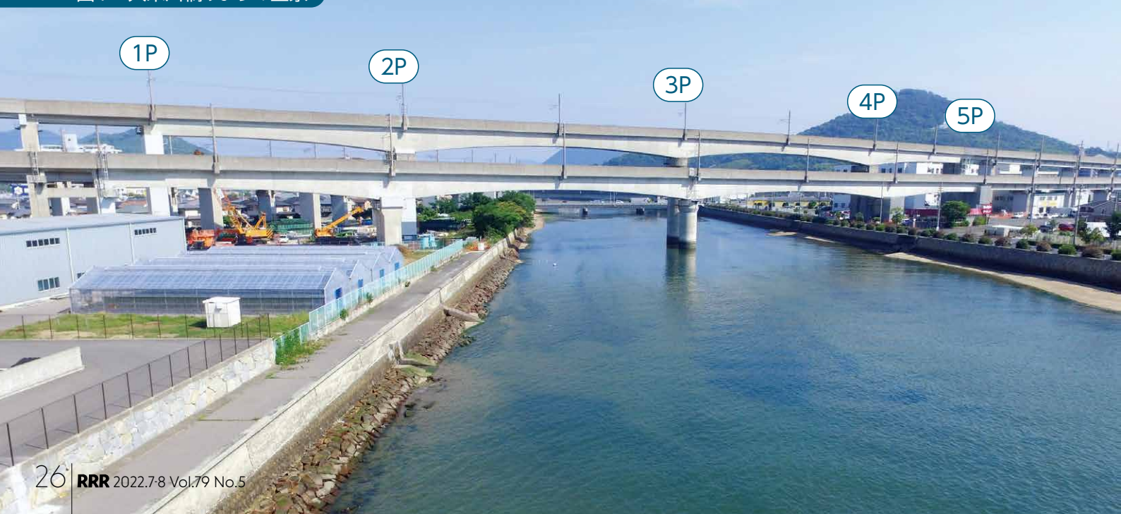
図1 大東川橋りょうの全景
