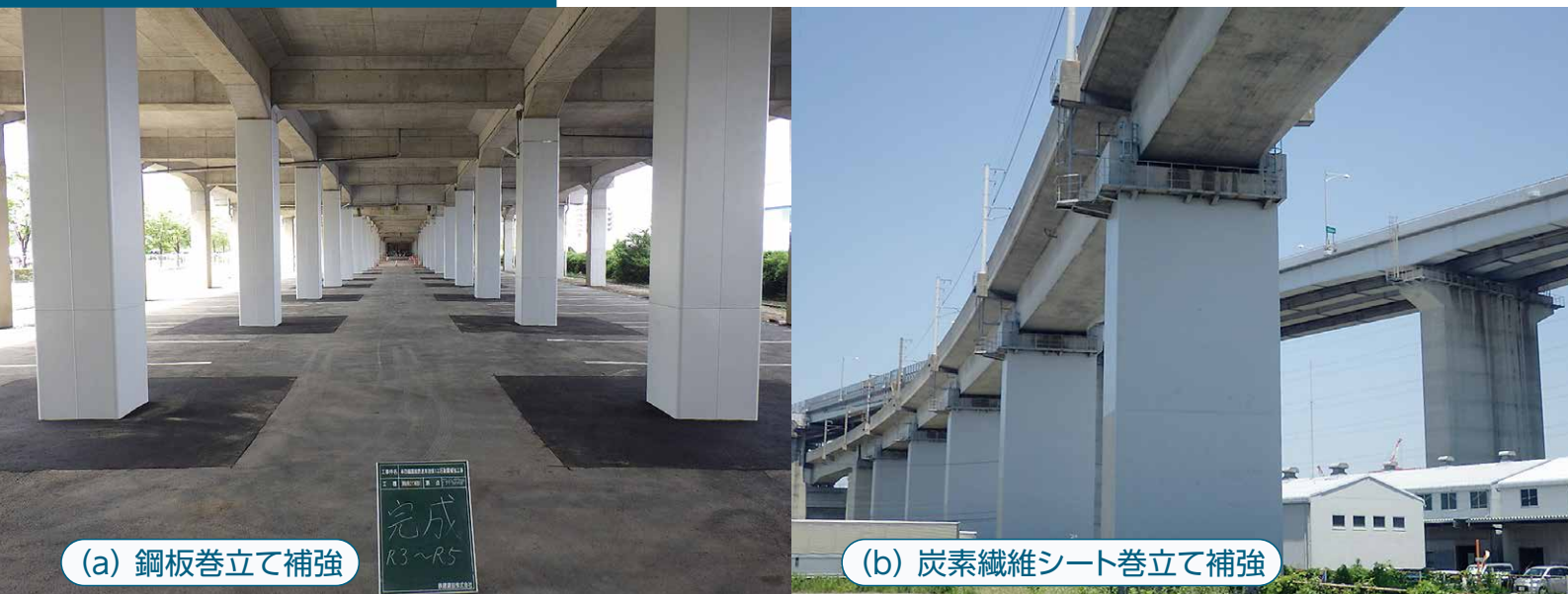
図5 一般箇所の耐震補強の様子
