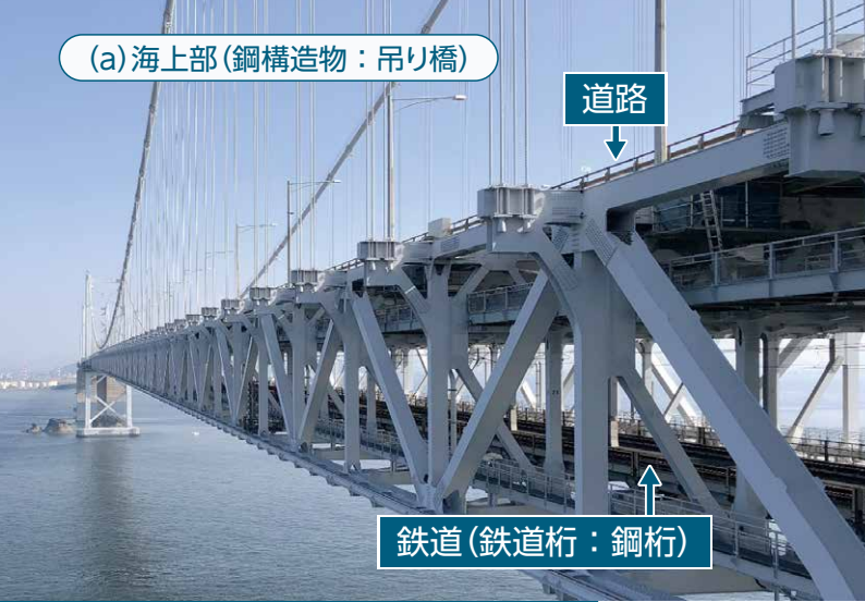
図2 鉄道道路併用橋の構造概要
