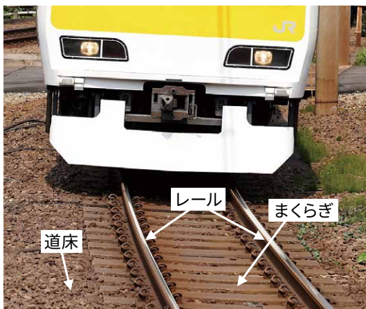
図1 レールとまくらぎを支える道床 (JR東日本撮影協力)
