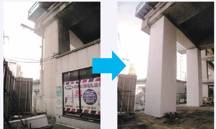
図5 鋼板巻立て補強例 6)
