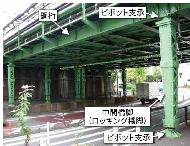
図1 ロッキング橋脚を有する橋りょう
