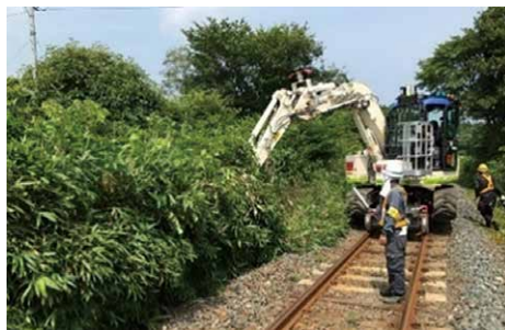
図4 沿線木伐採作業
