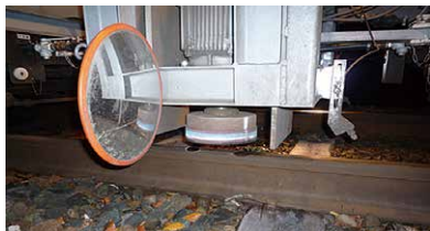
図2 レール研磨作業
