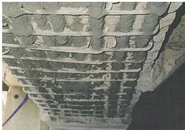
図2 塩分吸着剤入りモルタル施工後状況
