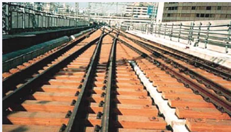
図6 分岐まくらぎとしての敷設状況 3)
