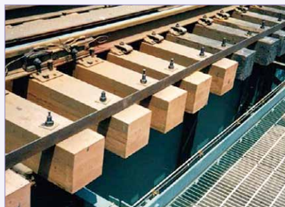
(a) 羽越本線三面川橋りょう
