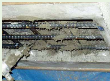
吹付け工法による断面修復例
