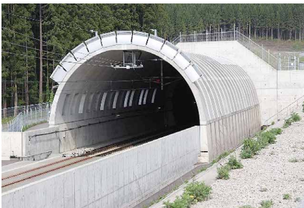
図1 トンネル緩衝工
