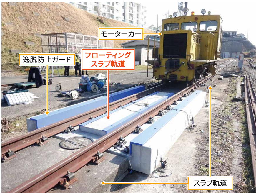
図6 モーターカー走行試験(日野土木実験所)
