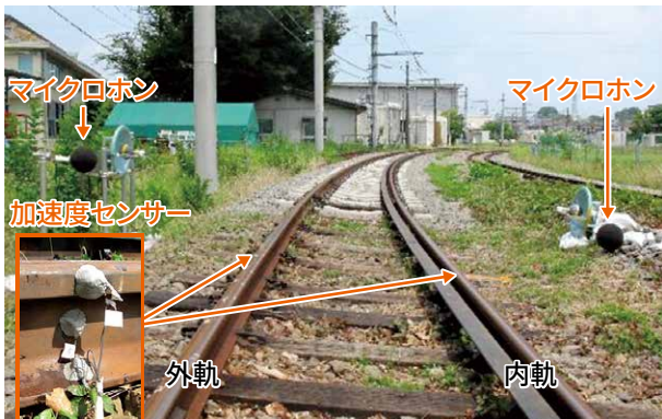
図4 地上側(曲線半径160m)の計測
