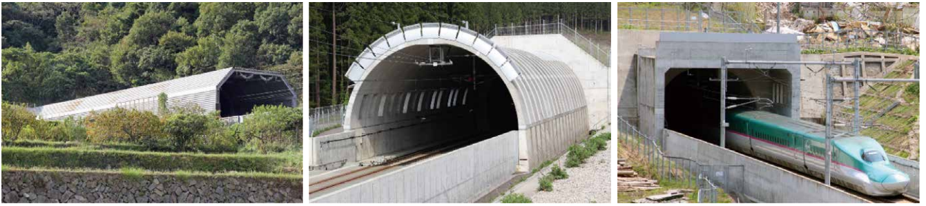
図2 新幹線における緩衝工の設置例
