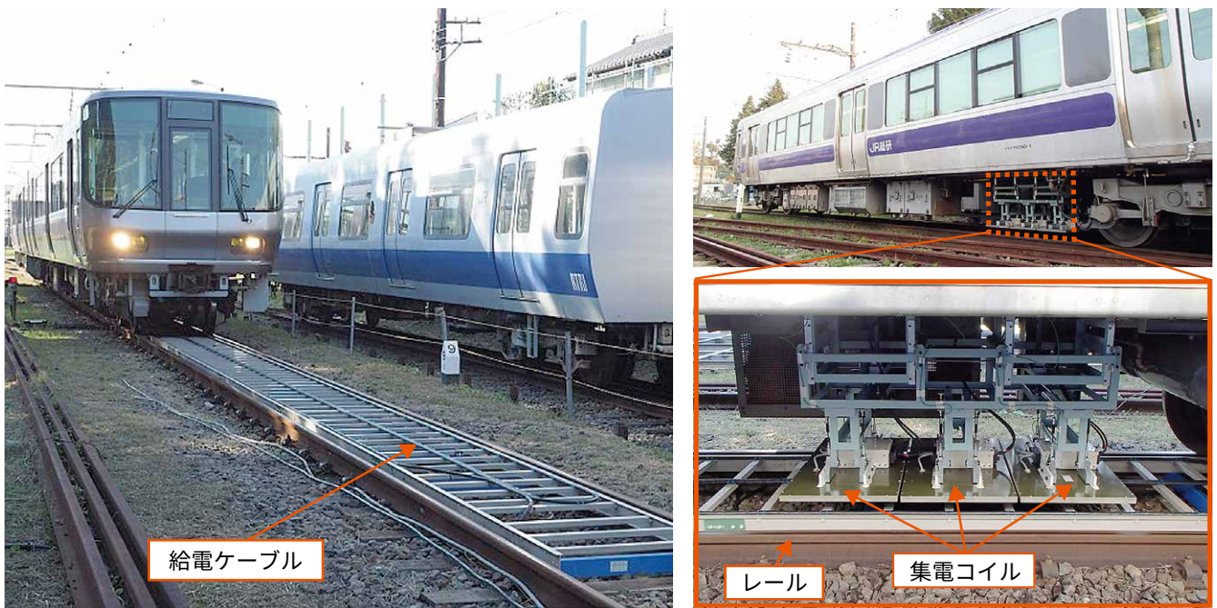
図5 試験電車を用いた実証試験の様子
