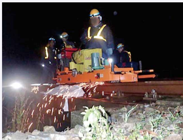
図11 レール削正装置
