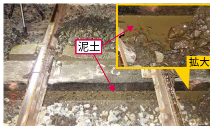
図1 細粒化が進行したバラスト (B地点：まくらぎ移動後)
