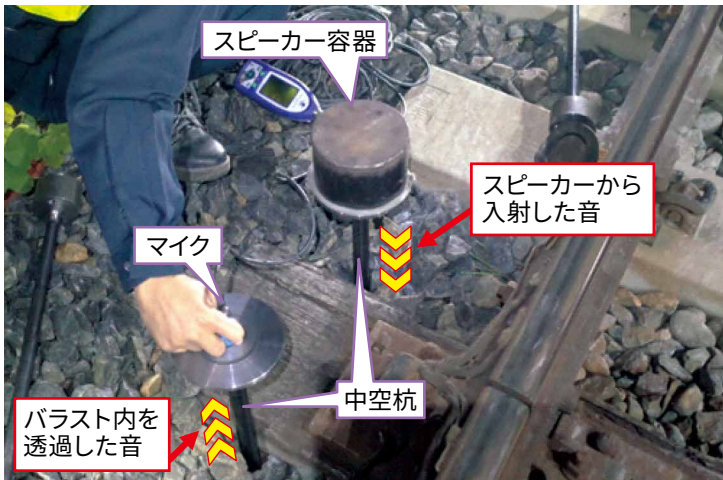
図10 透過音法 (杭方式) の測定状況
