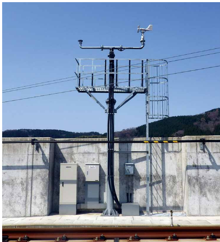
図1 風速計の設置イメージ
