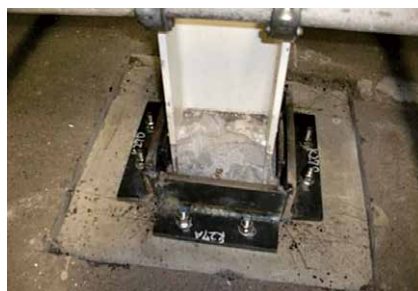
図2 柱脚補強
