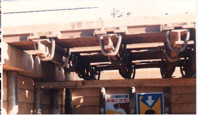
図4 軌条桁による列車荷重の仮受けの例 1)
