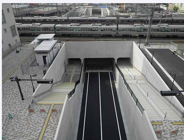
図1 単独立体交差の例(架道橋方式) 1)
