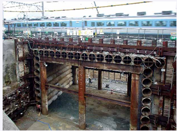
図6 パイプアーチ工法の例 4)
