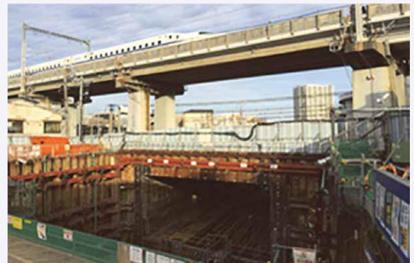
図11 JES工法での施工例 1)
