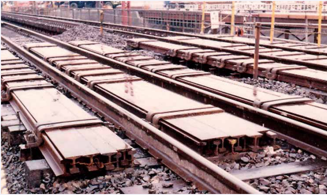
図4 軌条桁による列車荷重の仮受けの例 1)
