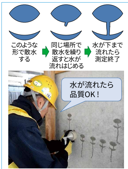
図2 コンクリート品質の散水試験
