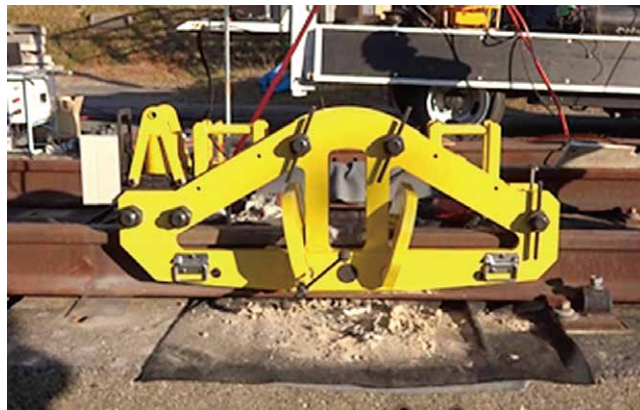
図 新型熱間矯正機による矯正状況(スラブ軌道)
