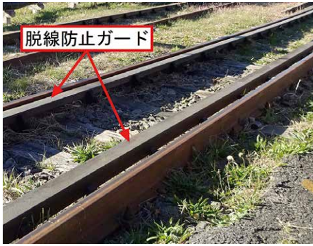
図2 在来線用脱線防止ガード
