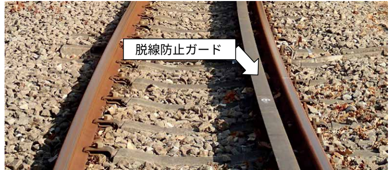
図4 脱線防止ガードの敷設例
