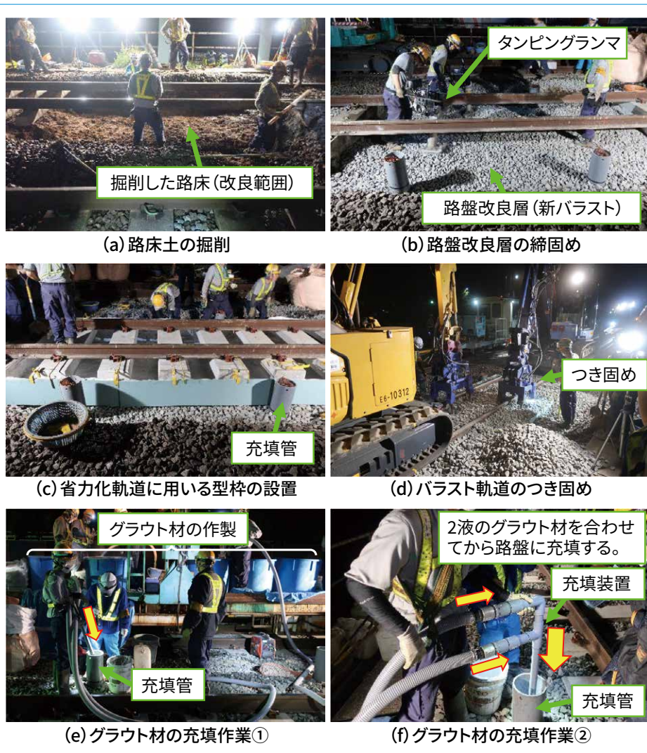
図8 試験施工の状況
