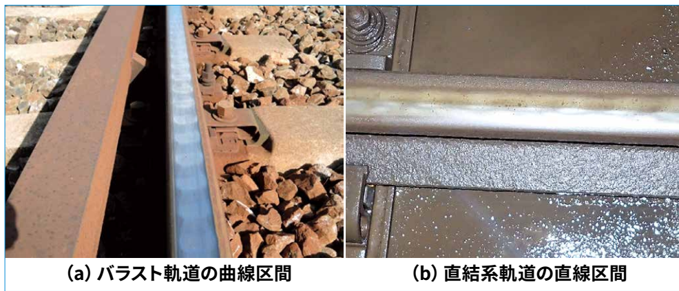
図1 レール波状摩耗の例
