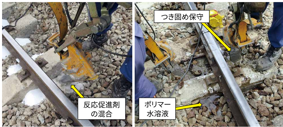
図6 ポリマー安定処理工法の施工状況
