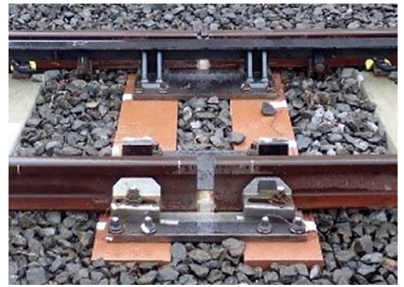
図10 遊間付伸縮継目構造
