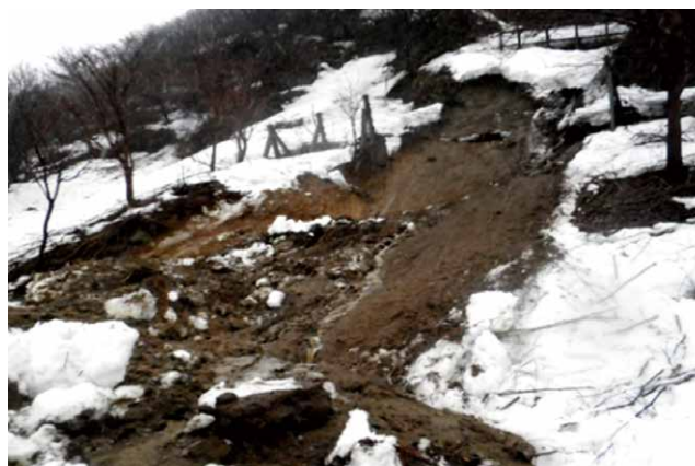
図 融雪期の斜面崩壊（融雪災害）の例
