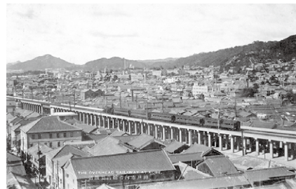
神戸市街高架線（写真は第一期工事完成時）
