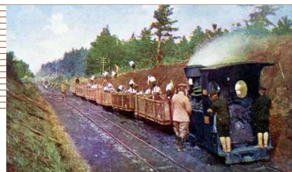
鉄道第一連隊による線路敷設演習
