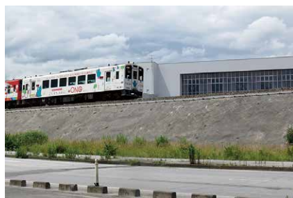
図2 盛地区のRRS工法 (のり面全面適用)
