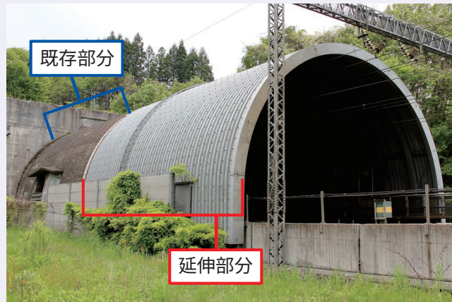
図5 列車の高速化にともなう既存緩衝工からの延伸
