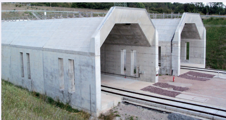
図8 ドイツの高速鉄道トンネルに設置されている70m緩衝工 8)
