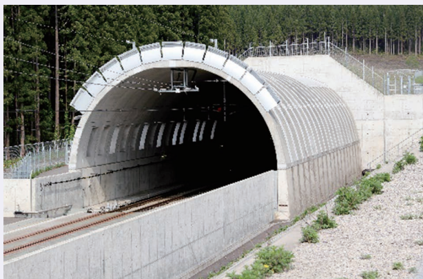
図2 実際のトンネル入口緩衝工
