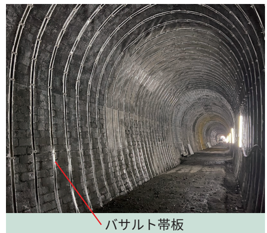
図3 施工完了状況
