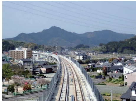
図10 軌道工事状況
